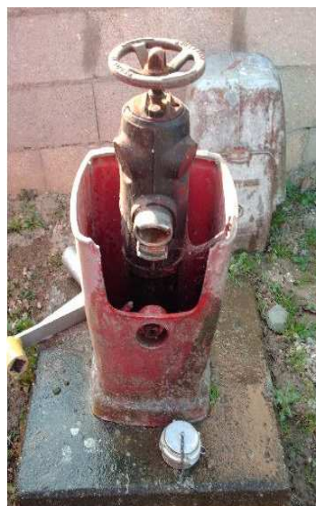
P I de 80 mm avec une sortie de 65 mm
